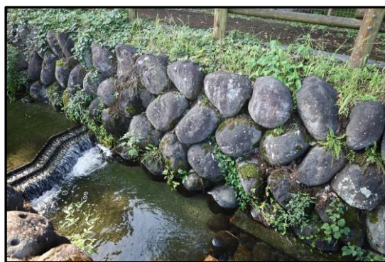
改修された石積み (笹堰・山形大学周辺)
